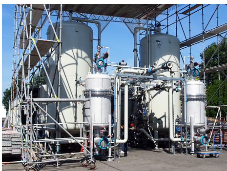
Vormontage im Werk
